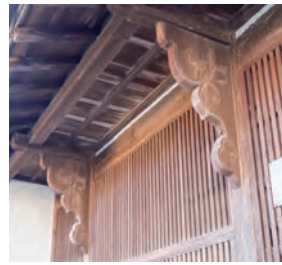
卯之町の町家では、軒下に装飾が施された「ひじ」と呼ばれる持送り(底を支える部材)が多くみられる。末光家住宅の「ひじ」は植物がモチーフ。
