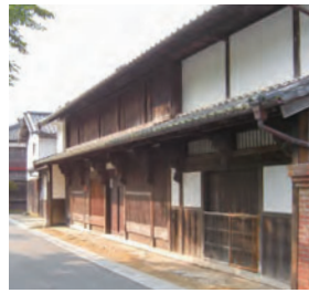
伝統的建築様式をのこす市指定文化財 末光(すえみつ)家住宅。
